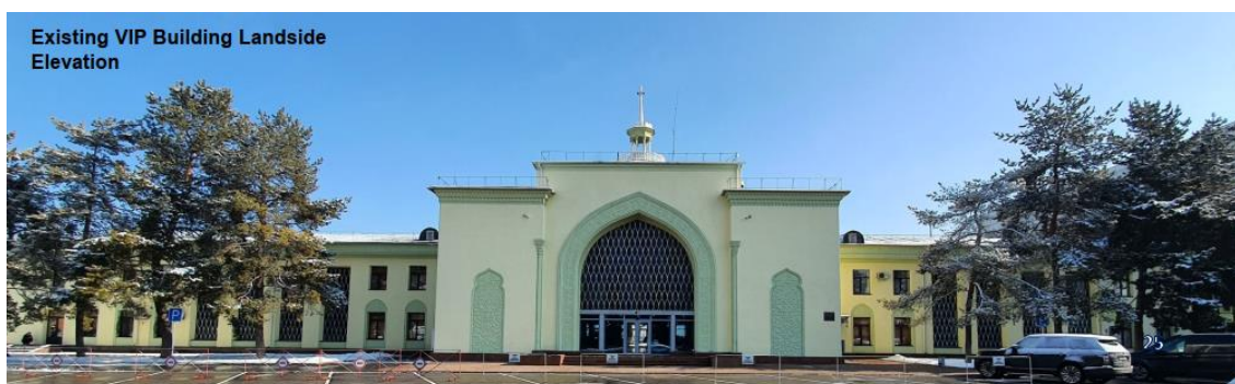
Фигура 2.5: Существующее VIP-здание, фасад со стороны общего доступа
